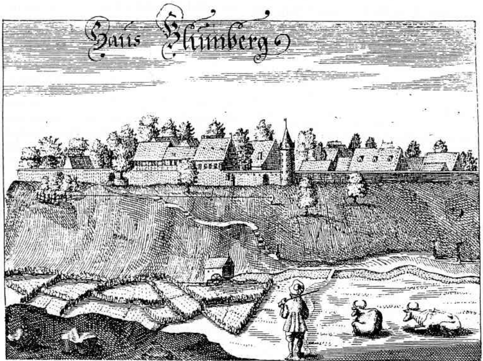
Abb 1: Ansicht der Burg Blomberg von Westen, rechts die Meierei mit dem Dach des „Steinhauses“. Kupferstich von Elias van Lennep 1663/66.
